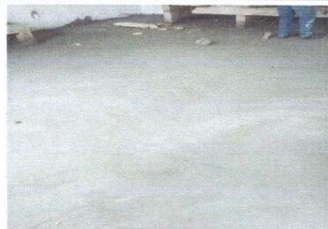
Foto 6: Módulo de cocina. Sustitución de piso de granito.
