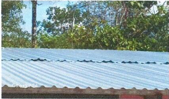
Foto 1: Módulo de cocina. Sustitución de lámina por lámina troquelada aluzing calibre 26.
