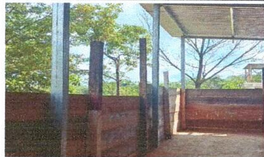
Foto 6: Módulo de aula. Sustrucción de soporte de madera por metal.
