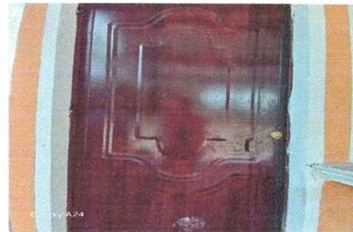
Foto 4: Módulo de cocina. Sustitución de puertas.
