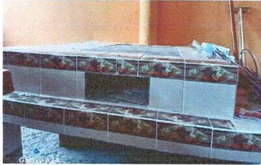
Foto 1: Módulo de cocina. Sustrucción de estufa rural (Completa) incluye chimenea y plancha de metal.
