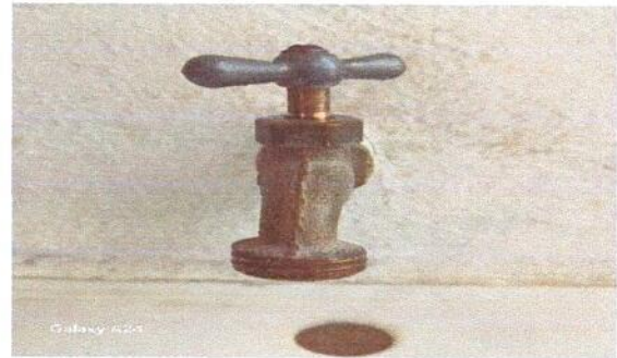
Foto 2: Módulo de cocina. Sustrucción de llave de chorro.
