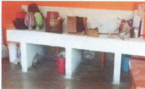
Foto 3: Módulo de cocina. Sustrucción de pila de cemento de dos lavaderos.
