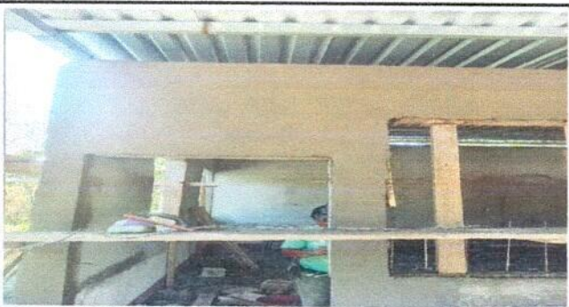
Foto 5. Módulo de cocina. Sustitución de balcones de metal
