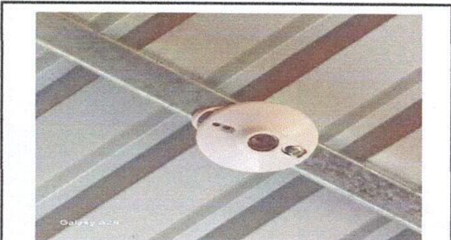
Foto 4: Módulo de cocina. Sustitución de plafonera
