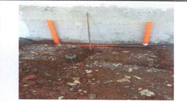
Foto 3: Módulo de cocina. Sustitución de tubería línea principal
