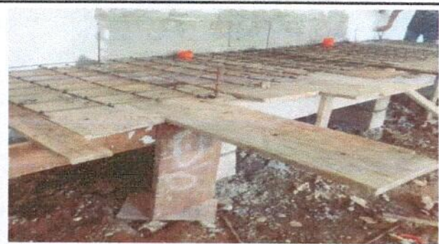
Foto 4: Módulo de aula. Sustrucción de pila de cemento de dos lavaderos.
