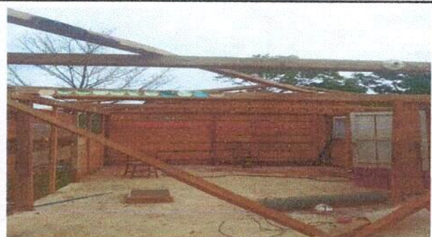
Foto 2: Módulo de cocina. Sustitución de elementos de fijación.
