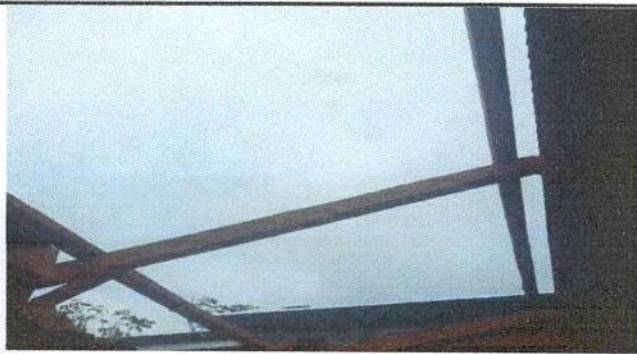
Foto 3: Módulo de cocina. Sustitución de estructura de soporte de madera por metal.
