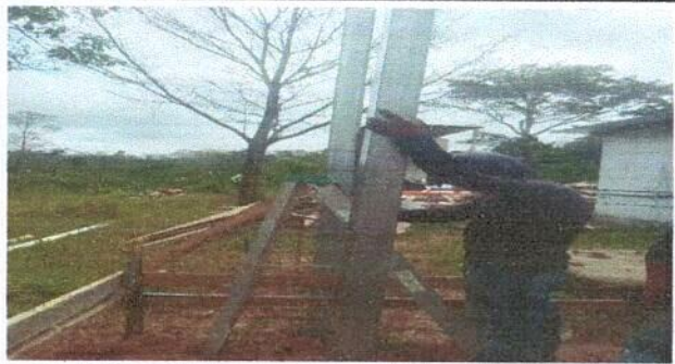
Foto 6: Módulo de aula. Sustrucción de soporte de madera por metal.
