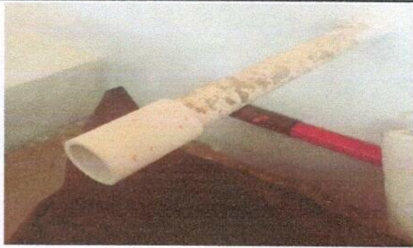
Foto 3: Módulo de cocina. Sustrucción de llave de chorro.
