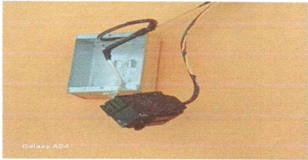
Foto 1: Módulo de cocina. Sustrucción de ducto electrico más accesorios.
