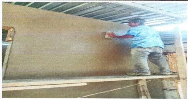
Foto 1: Módulo de cocina. Pintura en muro exteriores e interiores.
