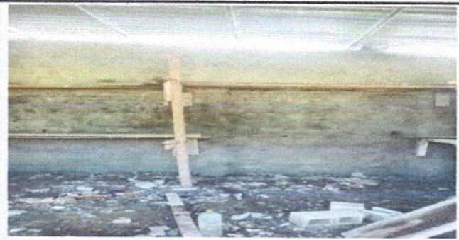
Foto 6: Módulo de cocina. Sustitución de piso de granito.
