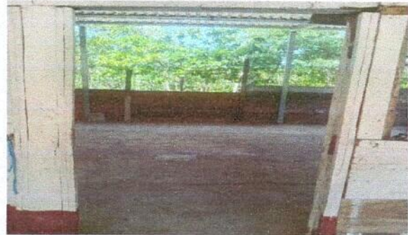
Foto 4: Módulo de cocnia. Sustitución de puertas.
