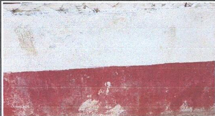
Foto 1: MODULO DE COCINA pintura en muro exteriores e interiores.
