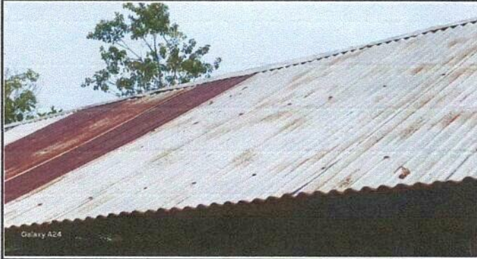
Foto 1: MODULO DE COCINA Sustitución de lámina por lámina trquelada aluzinc calibre 26
