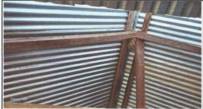
Foto 2: MODULO DE COCINA Sustitución de elementos de fijación
