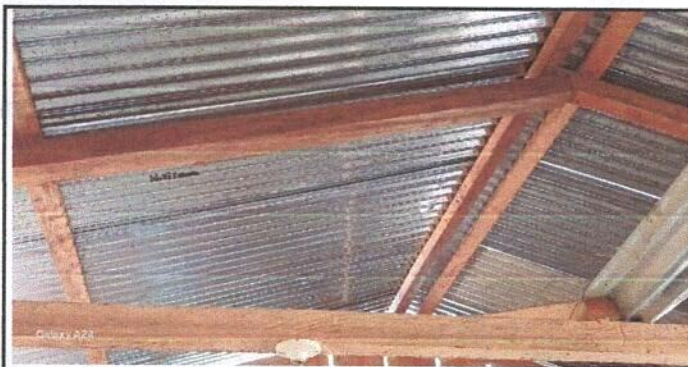
Foto 5: MODULO DE AULA Sustitución de elementos de fijacion.
