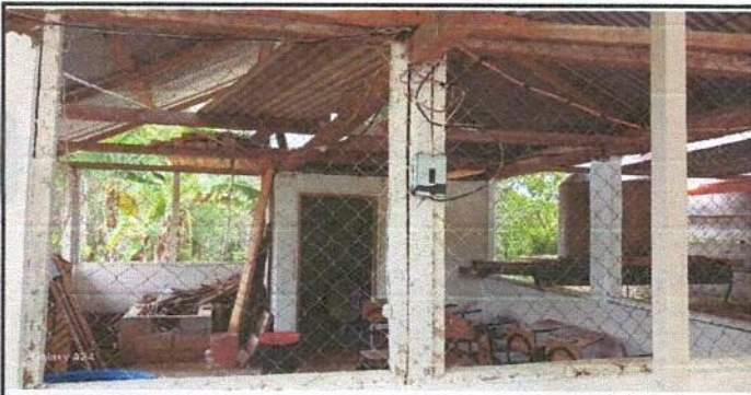
Foto 5: MODULO DE COCINA Sustitución de balcones de metal
