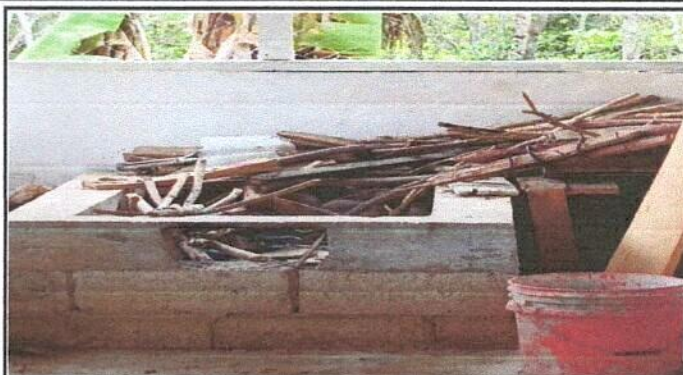
Foto 2: MODULO DE COCINA Sustitución de estufa rural (completa) incluye chimenea y plancha de metal.
