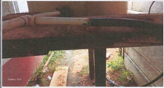
Foto 3: MODULO DE COCINA Sustitución de tubería línea principal.
