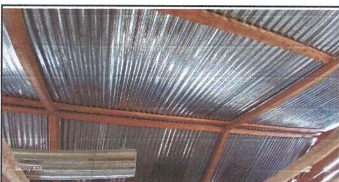
Foto 6: MODULO DE AULA Sustitución de soporte de madera por metal.
