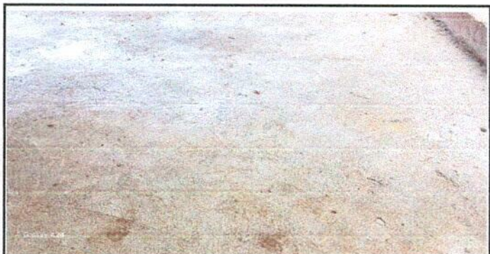
Foto 6: MODULO DE COCINA Sustitución de piso de granito
