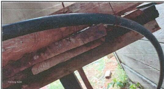
Foto 1: MODULO DE COCINA Sustitución de ducto eléctrico mas accesorios.
