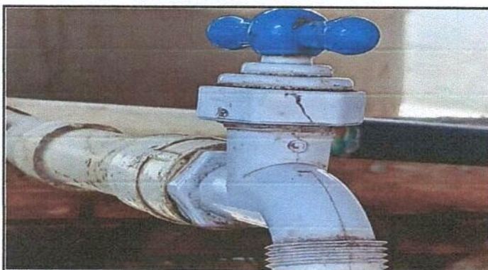
Foto 3: MODULO DE COCINA Sustitución de llaves de chorro.
