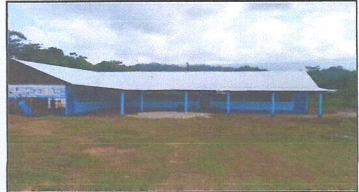
Foto 4: Sustitución de láminas deterioradas módulo de aulas.
