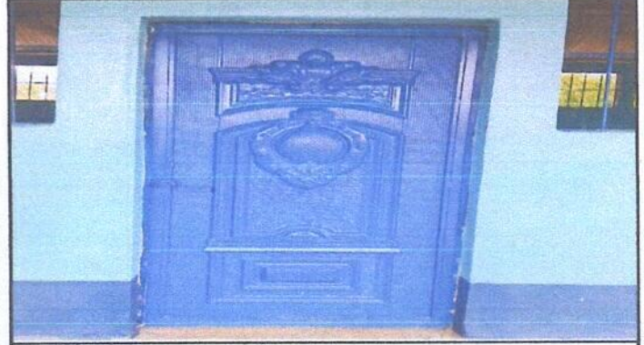
Foto 2: Techado y puerta metálica de la cocina.
