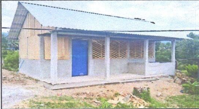
Foto 1: Sustitución de láminas a láminas troqueladas y repello en muro módulo de cocina.
