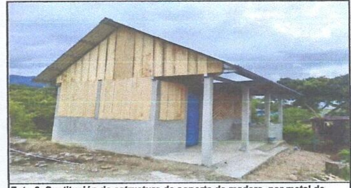
Foto 6: Sustitución de estructura de soporte de madera, por metal de módulo de cocina.
