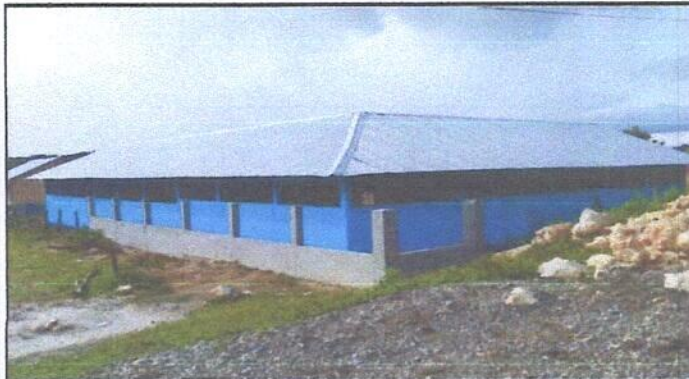
Foto 3: Reparación de muro perimetral de block.
