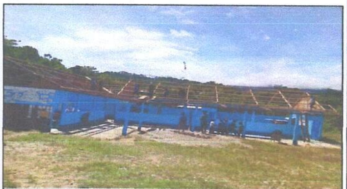
Foto 4: Sustrucción de láminas deterioradas módulo de aulas.
