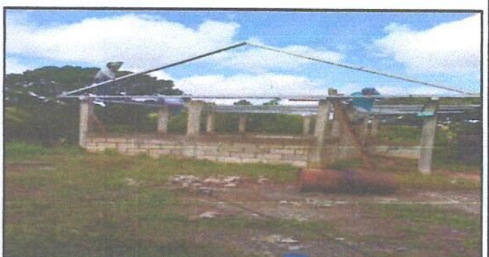
Foto 6: Sustrucción de estructura de soporte de madera, por metal de módulo de cocina.
