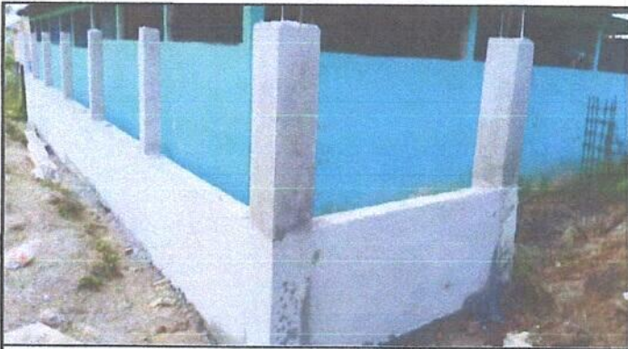
Foto 3: Reparación de muro perimetral de block.
