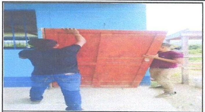
Foto 2: Sustrucción de puertas de madera a puertas metálicas módulo de aulas.
