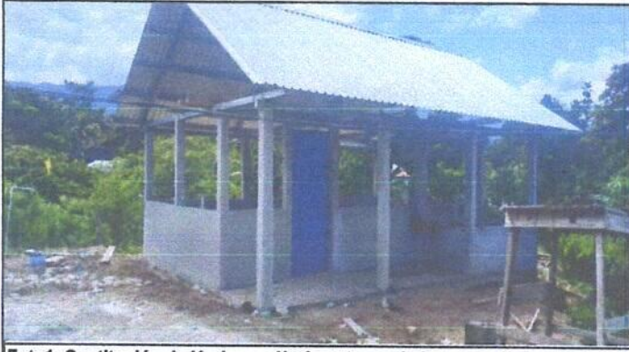
Foto 1: Sustrucción de láminas a láminas troqueladas y repello en muro módulo de cocina.
