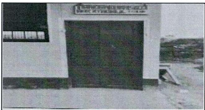
Foto 6: Sustrucción de puerta de madera por metal
