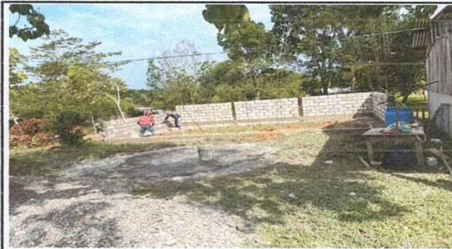
Foto 1: Inicio de construcción de cocina
