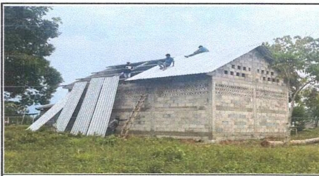
Foto 5: colocación de techo
