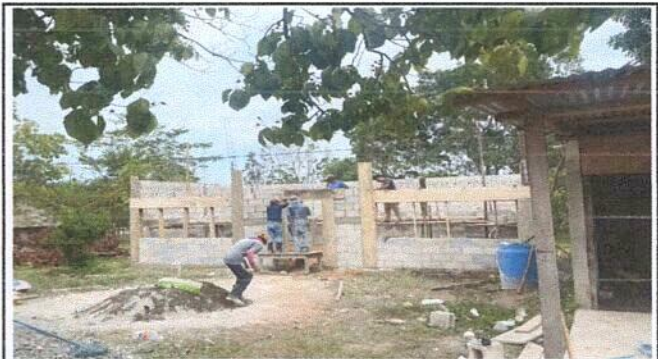
Foto 2: Fundición de columnas
