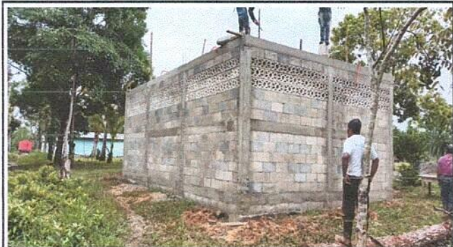
Foto 4: Parte lateral de techo de cocina
