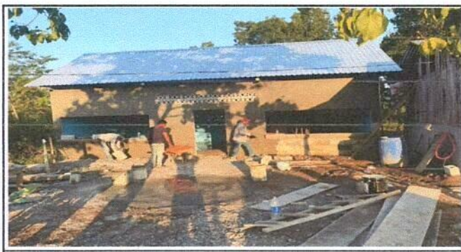
Foto 6: Repello de construcción
