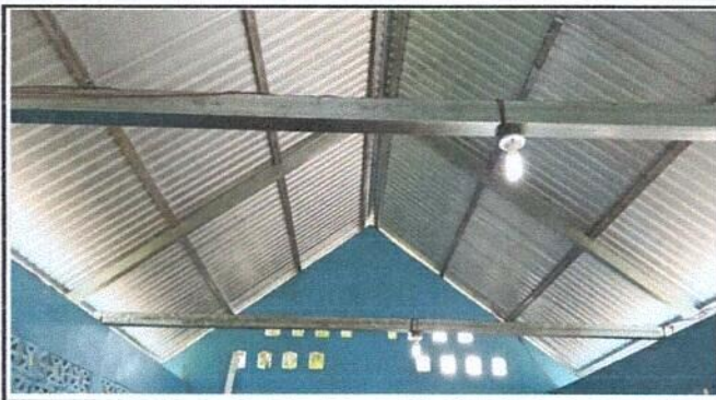
Foto1: Estructura de techo y energia electrica
