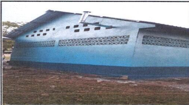
Foto 3: Vista de chimenea de estufa rural.
