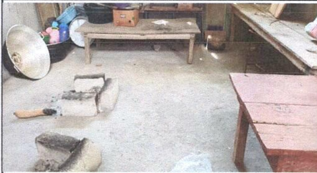
Foto 1: Sustitución de piso de torta de cocina lado izquierdo.
