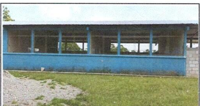
Foto 6: Aulas para sustitución de malla por balcon
