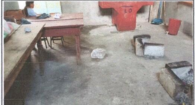
Foto 2: piso de cocina parte interior lado derecho-
