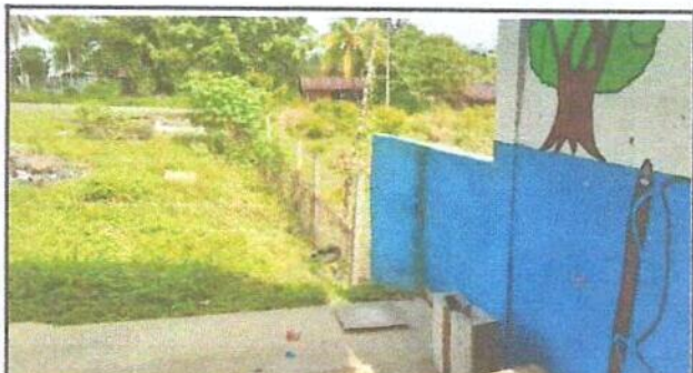
Foto 4: Lado este del Perimetro escolar.
