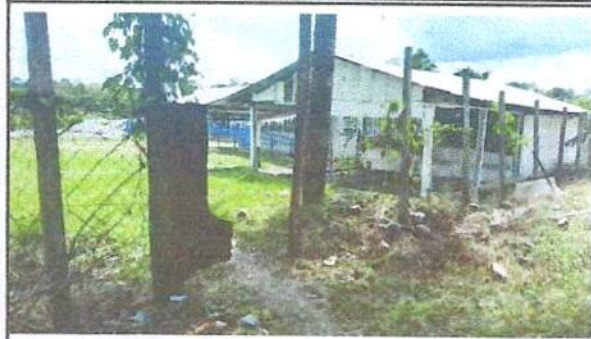
Foto 2: Vista del portón.
