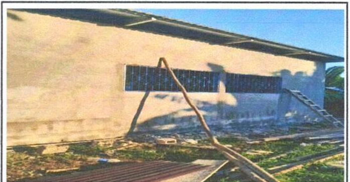
Foto 4: Sustitucion de balcones.
