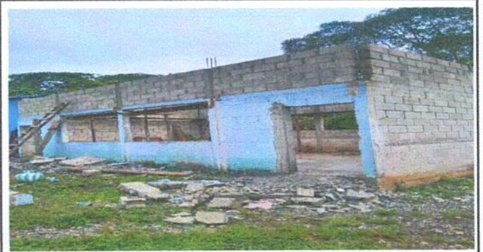
Foto 2: Techado general por laminas troqueladas y parte de estructuras metalicas.
