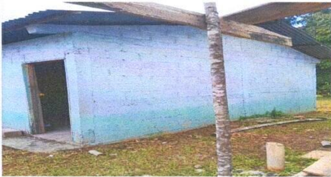
Foto 1: Area de de la puerta que se modificaran.
