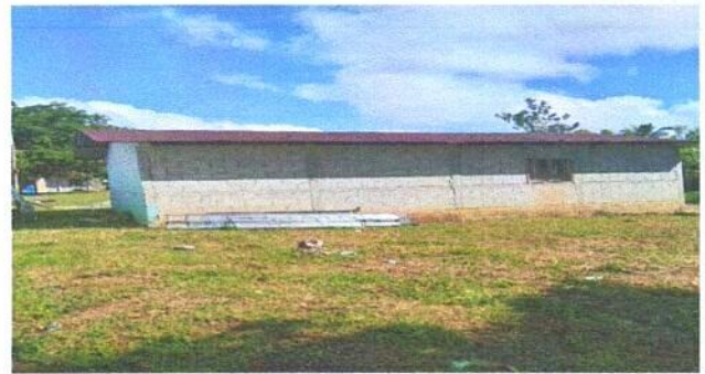
Foto 4: Sustitucion de balcones.
