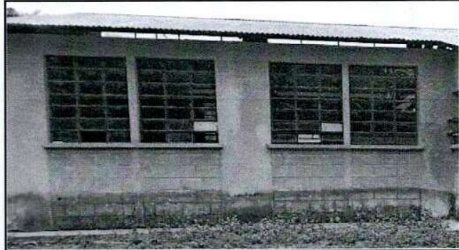
Foto 2: Sustitución de vidrios de ventanas.
