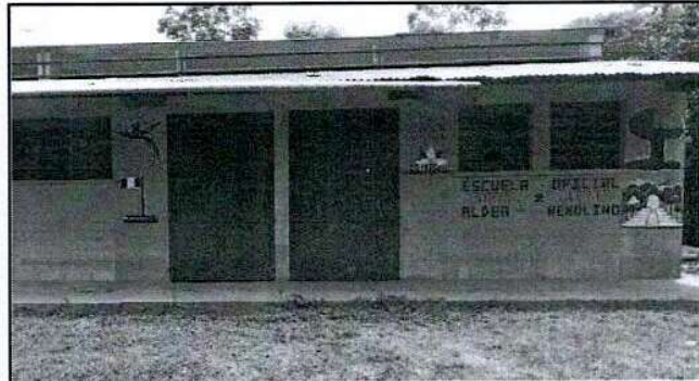
Foto 4: Sustitución de puertas de metal por puertas de metal.
