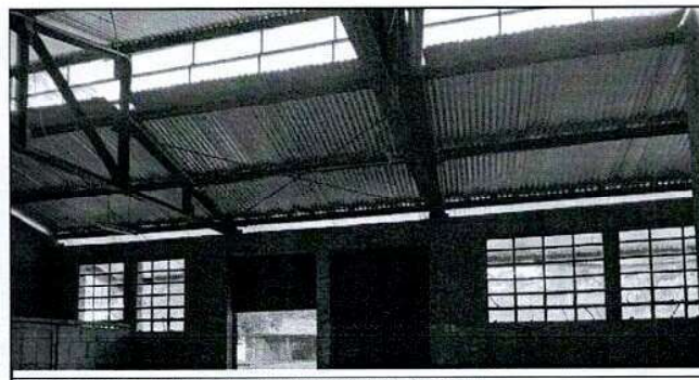
Foto 6: Mantenimiento de estructura soporte de metal
