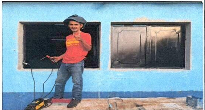
Foto 4: INSTALACION DE VENTANAS
