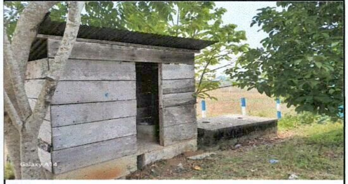
Foto 2: Vista de los servicios sanitarios
