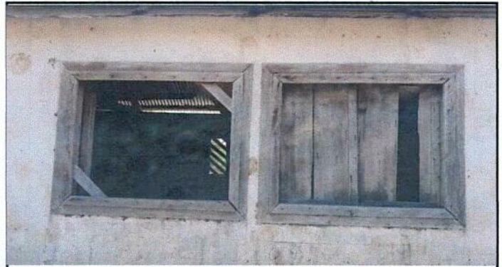
Foto 4 : Vista de las ventanas a sustituir por metal
