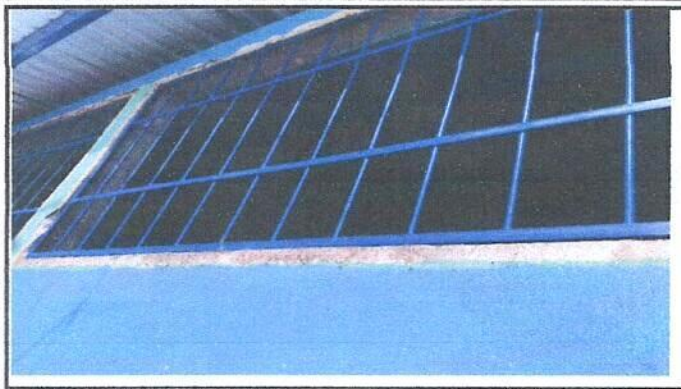
Foto 2: Sustitucion de ventanas
