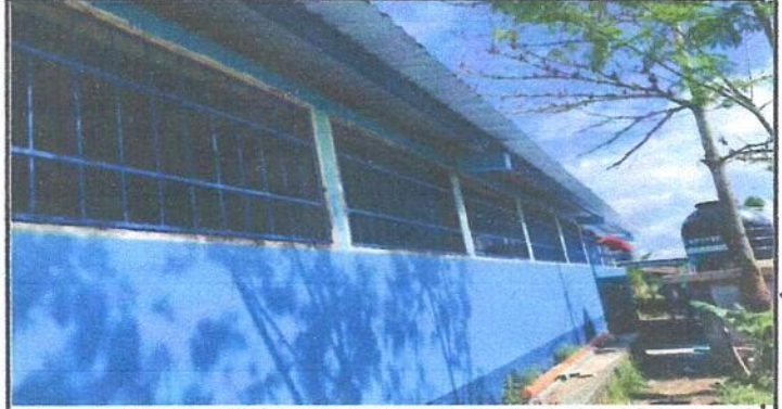
Foto 2: Sustitucion de Valcones
