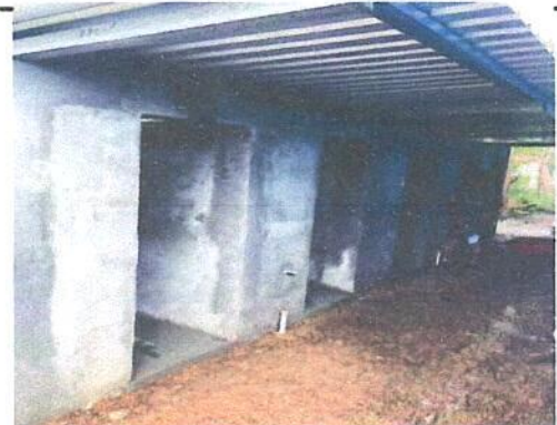
Foto 4: Sustitucion de baños
