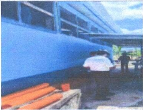
Foto 3: Sustitucion de Ventanas
