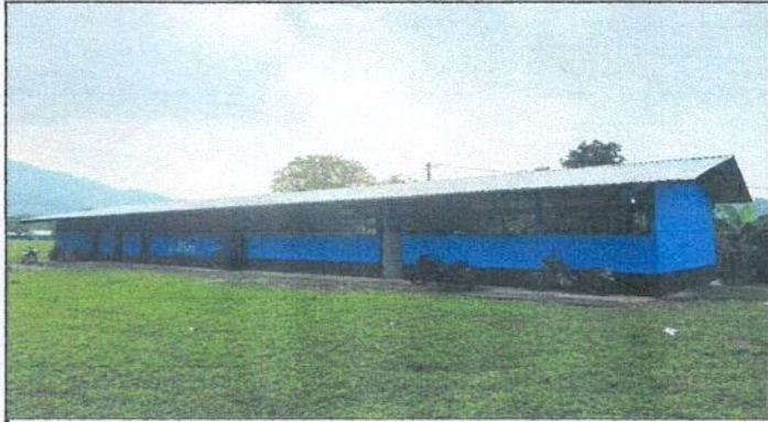
Foto1: Sustitución de lamina, por lámina troquelada
