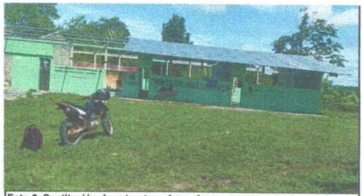
Foto 6: Sustitución de estructura de madera por estructura de metal
