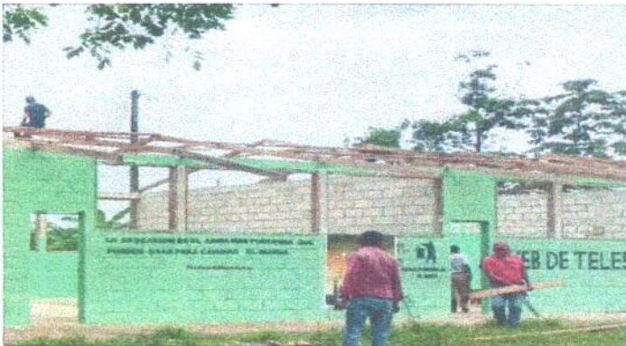
Foto 3: Sustitución de elementos de fijación
