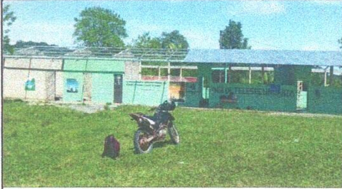
Foto 1: Sustitución de lamina, por lámina troquelada
