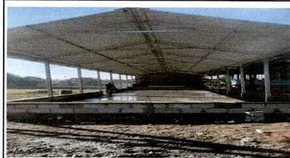
Foto 3: bigas y toda la estructura metalica finalizada.
