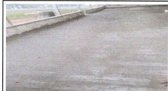
Foto 4: Reparación y ampleción del corredor finalizado.
