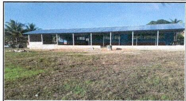
Foto 2: Material de la cubierta de lamina finalizada.
