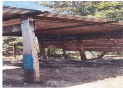
Foto 4: Reparacion de techo del establecimiento
