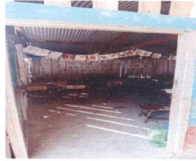
Foto 2: Estado actual de módulo de aulas.
