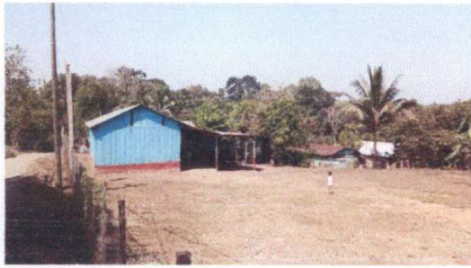
Foto 1: Estado actual de módulo de aulas.
