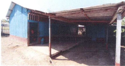
Foto 3: Reparacion de piso de torta de concreto.
