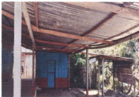
Foto 5: reparacion de lamina por lamina troquela
