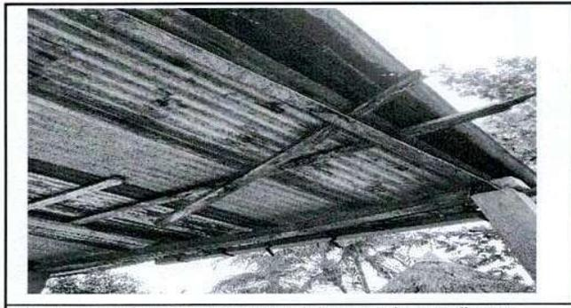
Foto 6: soporte temporal de madera colocao por los estudiantes evitando la desintegración de la estructura del techo
