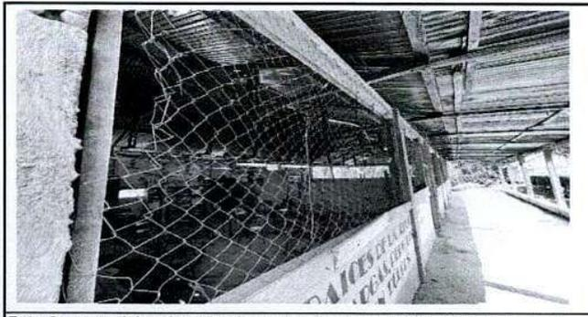
Foto 5: parte del techo dañado con agujeros que filtra el agua hacia las aulas en temporada de invierno
