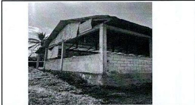
Foto 4: vista techado frontal despegado por el viento. laminas rotas
