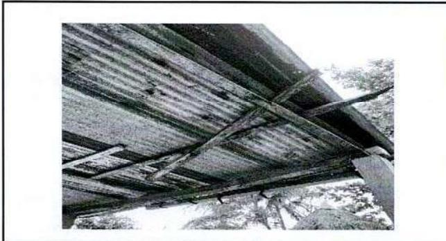
Foto 1: parte estructural del techo con mayor daño de deterioro en la madera
