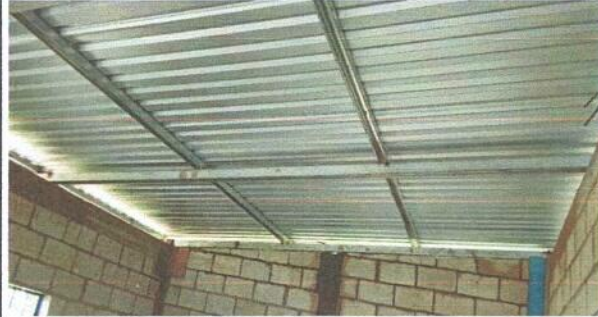
Foto 2: sustitucion de lamina.
