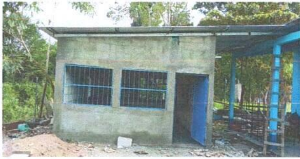
Foto1: sustitucion de pared de madera por block.
