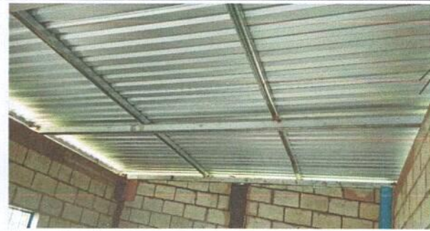
Foto 3: sustitucion de estructura de madera.
