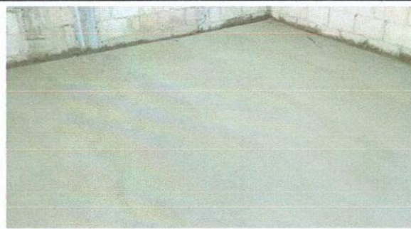
Foto 2: reparacion de torta de concreto
