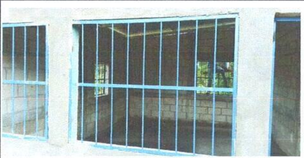
Foto 4: sustitucion de ventana.
