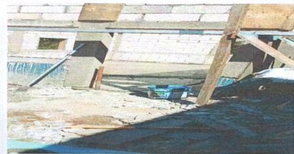
Foto 5: sustitucion de puerta
