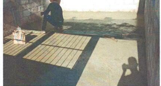
Foto 2: reparacion de torta de concreto.
