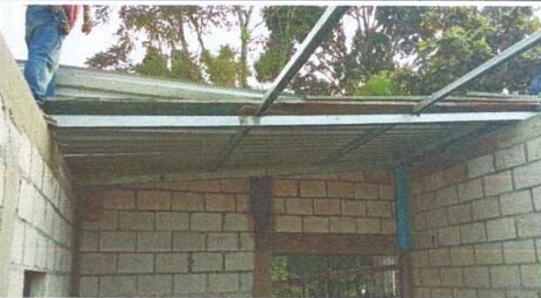
Foto 3: sustitucion de estructura de madera.
