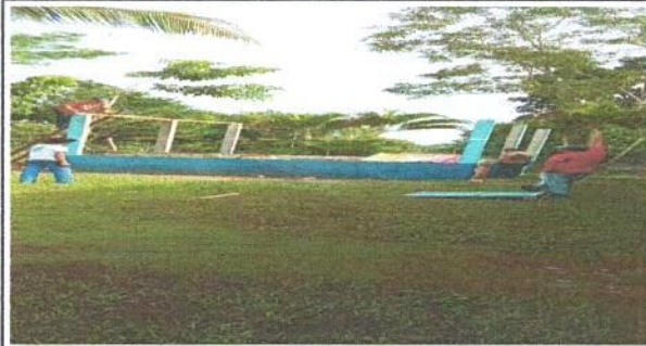
Foto 2: sustitucion de lamina.
