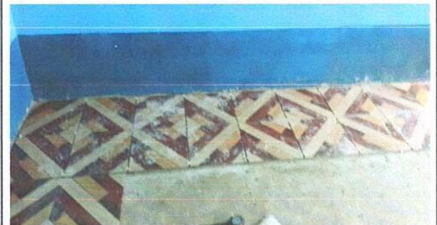
Foto1: cambio de piso de torta por piso ceramico.
