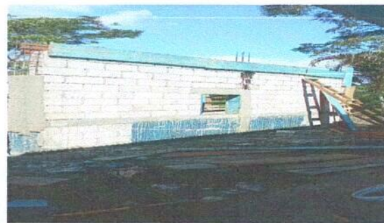
Foto 4: sustitucion de ventana.
