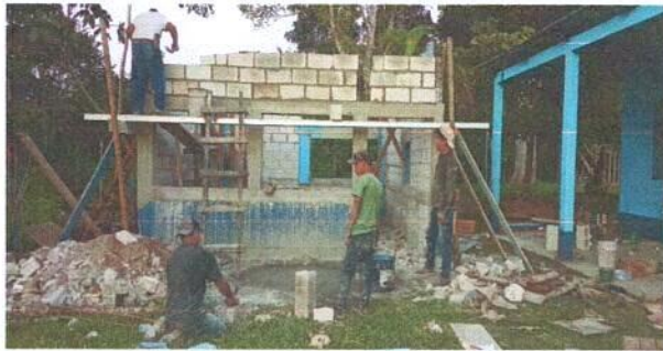
Foto1: sustitucion de pared de madera por block.
