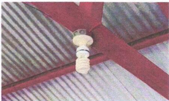
Foto 3: Sustitución de focos
