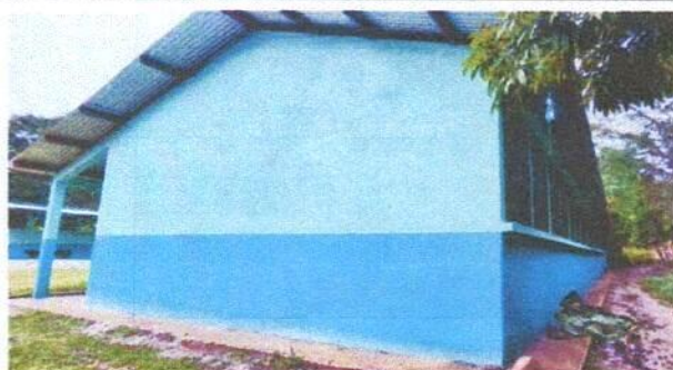
Foto 6: Repello en muros
