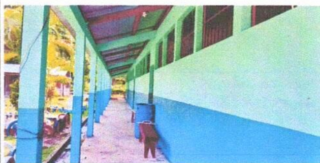
Foto 2: Pintura en muros interiores y exteriores
