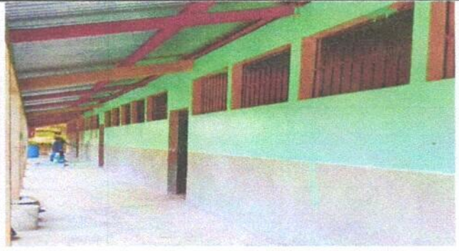
Foto 2: Pintura en muros interiores y exteriores
