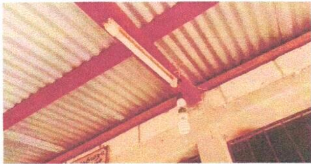
Foto 3: Sustitución de focos
