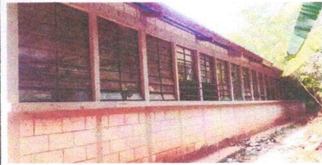
Foto1: Sustitución de ventas de vidrios por ventanas de metal
