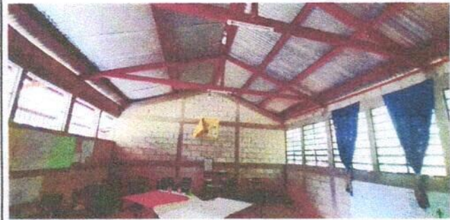
Foto 4: Sustitución de plafoneras
