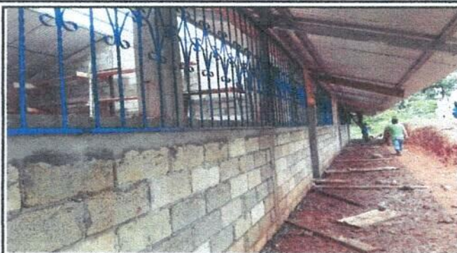
Foto 2: Instalación de balcones de metal
