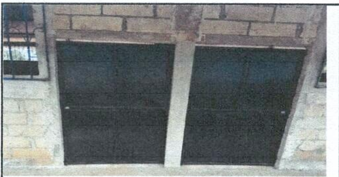
Foto 5: Sustitución de puerta de madera por metal.
