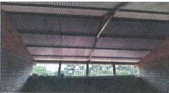
Foto 4: Instalación de estructura portante de metal
