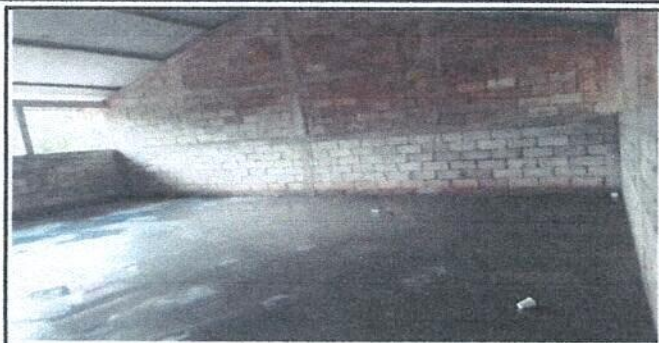
Foto1: Sustitución de piso de torta de concreto
