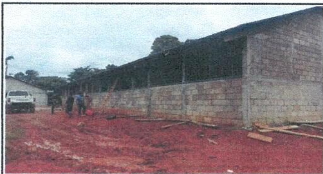
Foto 3: Instalación de balcones de metal.
