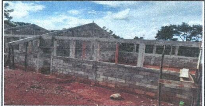
Foto 2: Instalación de balcones de metal
