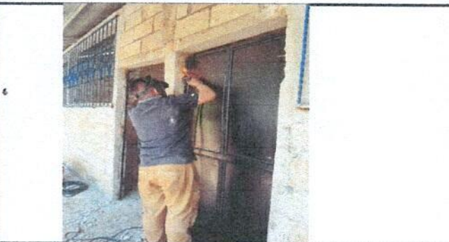
Foto 5: Sustitución de puertas de madera por metal
