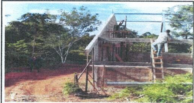
Foto 4: Instalación de estructura portante de metal
