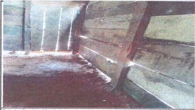
Foto1: Sustitución de torta de concreto
