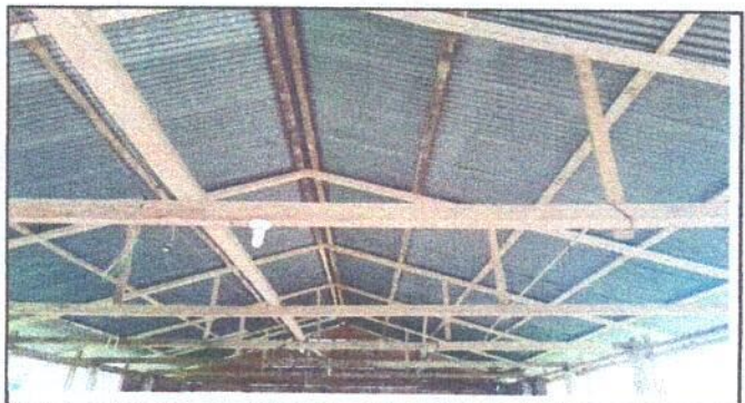
Foto 4: Instalación de estructura portante de metal
