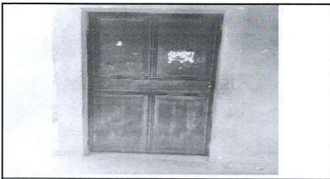
Foto 5: Sustitución de puerta
