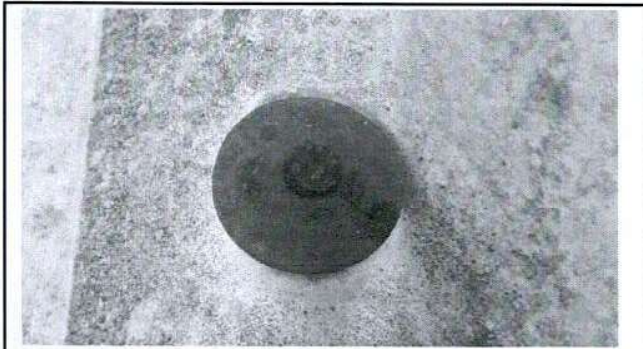
Foto 3: Sustitución de elementos de fijación
