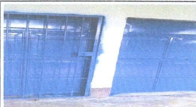
Foto 4: Sustitución de puerta de madera por metal
