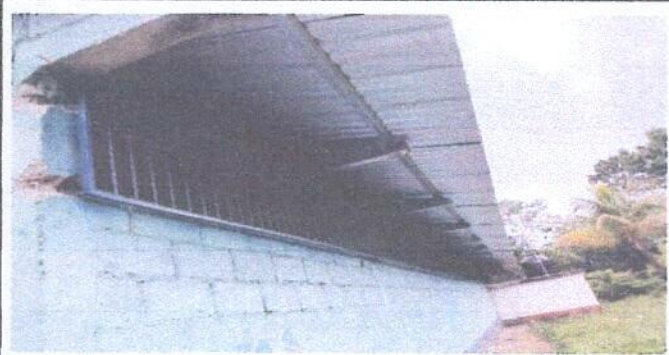
Foto 5: Sustitución de balcones de metal parte de atrás
