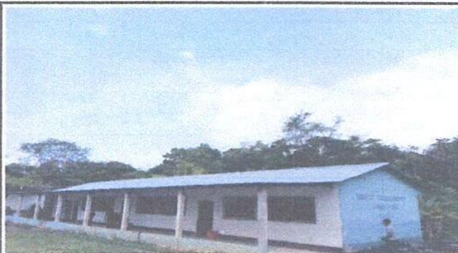
Foto 2: Sustitución de Capote de lámina, por lámina troquelada
