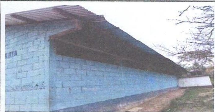
Foto 5: Sustitucion de Balcones de Metal parte de atrás
