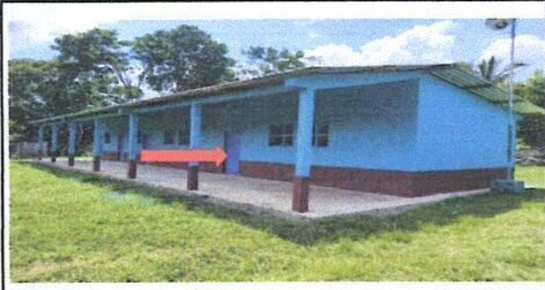
Foto 2: Sustitución de puertas
