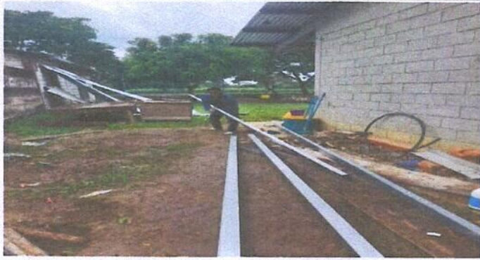
Foto 1: Vista de la parte del techo durante el trabajo del techado de la cocina, tomada del angulo sur. (sin techo)
