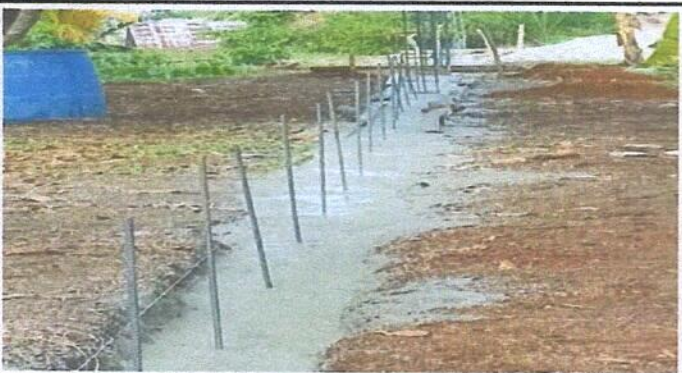
Foto 3: Vista externa del muro perimetral del centro educativo durante el trabajo, tomada del angulo sur (fundicion del muro perimetral)
