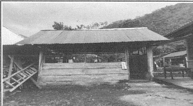
Foto1: Sustitución de lámina por lámina troquelada alazine calibre 26
