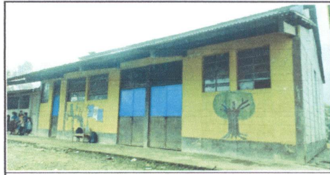
Foto 6: Repello y pintura de muros interiores y exteriores.
