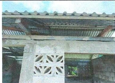
COCINA/Sustitución de estructura de soporte de madera por metal.
