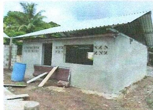
COCINA/Sustitución de láminas por láminas troqueladas aluzinc calibre 26.
