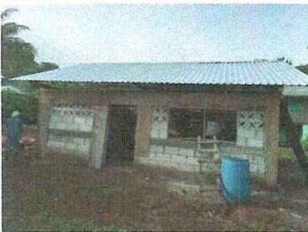
COCINA/Sustitución de capote de lámina para lámina troquelada.
