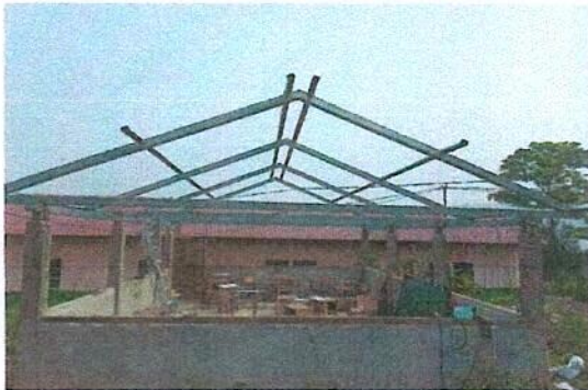
Sustitución de estructura de soporte de madera por metal del centro educativo.
