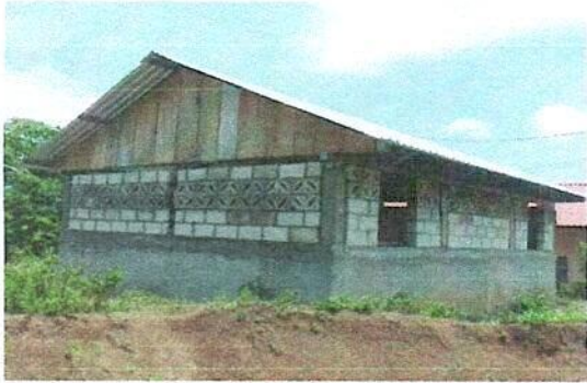
Sustitución de láminas por láminas troqueladas aluzinc calibre 26 del centro educativo.
