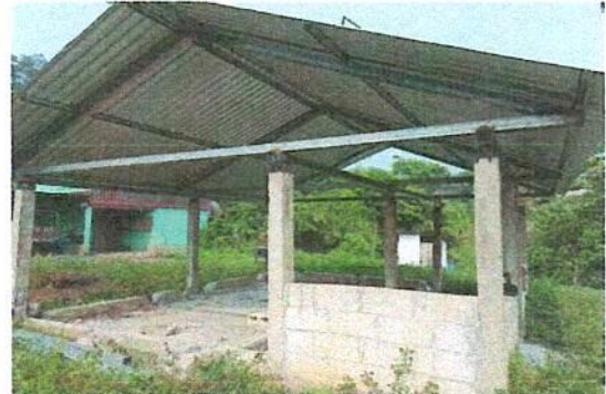
COCINA/Sustitución de láminas por láminas troqueladas aluzinc calibre 26.
