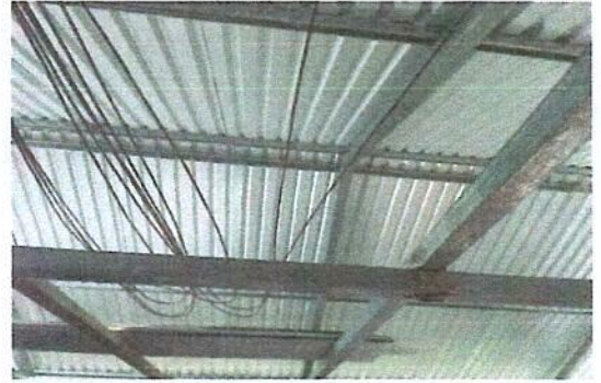
Sustitución de capote de lámina para lámina troquelada, del centro educativo.
