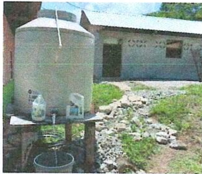
Sustitución de depósitos de agua 1,100lt
