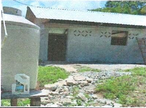
COCINA/Sustitución de puerta
