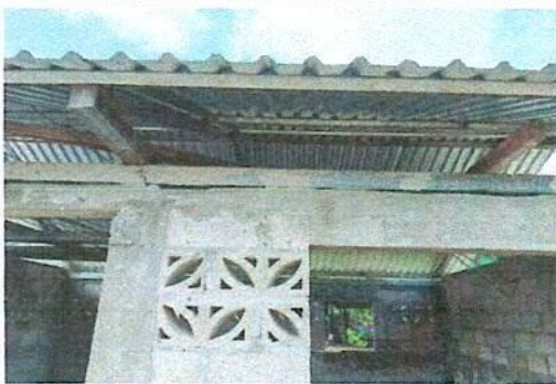
COCINA/Sustitución de capote de lámina para lámina troquelada.
