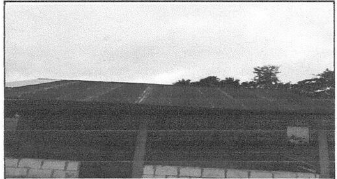
FOTO 4: COCINA/Sustitución de láminas por láminas troqueladas aluzinc calibre 26.
