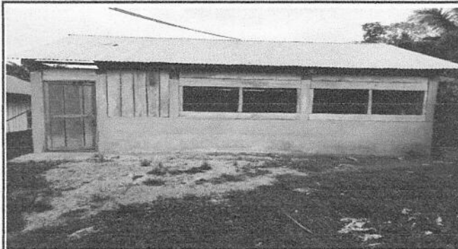
FOTO 1: Sustitución de láminas por láminas troqueladas aluzinc calibre 26 del centro educativo.
