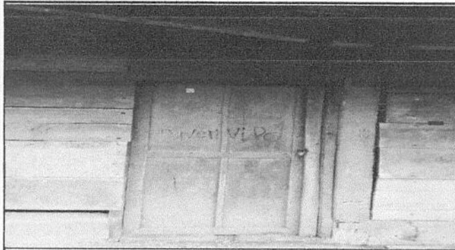
FOTO 7: COCINA/Sustitución de puerta
