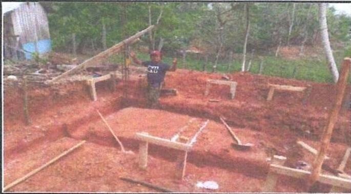
Foto1: Contruccion del cimiento para las paredes.
