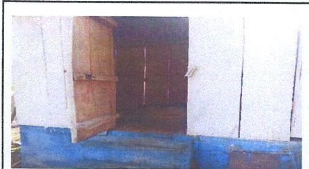
Foto 3 Sustitucion de puertas en servicios sanitarios
