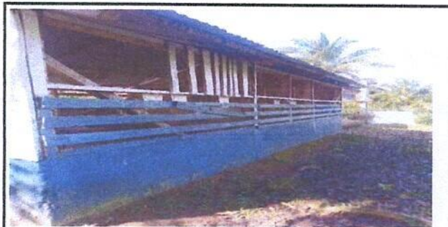
Foto 6 Repello en muro
