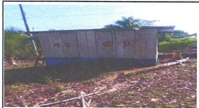
Foto 2 Sustitucion de estructura de soporte de madera por metal
