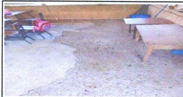
Foto 4 Reparacion de piso de torta de concreto
