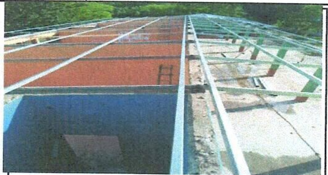
Foto 2: sustitucion de elementos de fijación.
