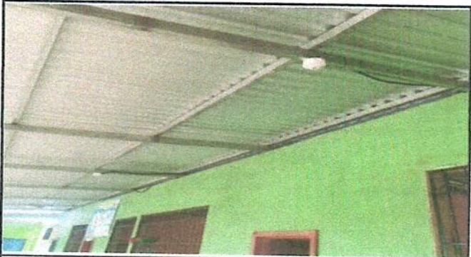
Foto 3: sustitucion de focos ahorradores.
