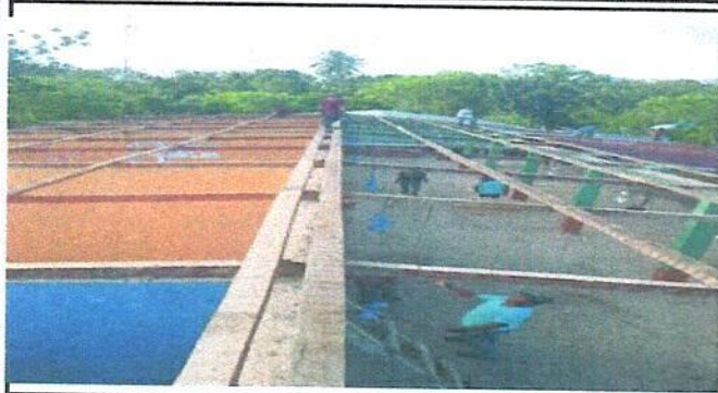
Foto 1: sustitucion de lamina.
