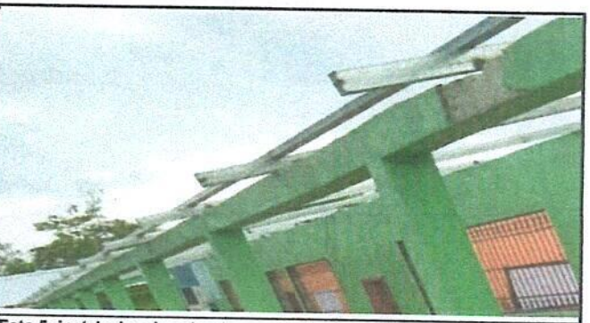
Foto 5: instalacion de estructura cortante de metal.
