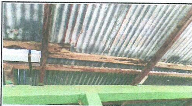
Foto 4: sustitucion de estructura de soporte de madera por metal.
