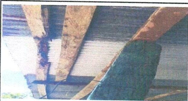
Foto 5: instalacion de estructura cortante de metal.
