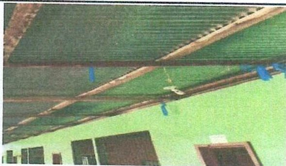
Foto 3: sustitucion de focos ahorradores.
