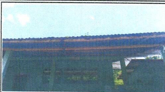
Foto 2: sustitucion de elementos de fijación.
