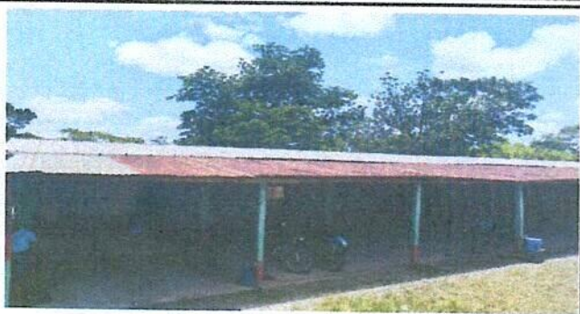
Foto1: sustitucion de lamina.
