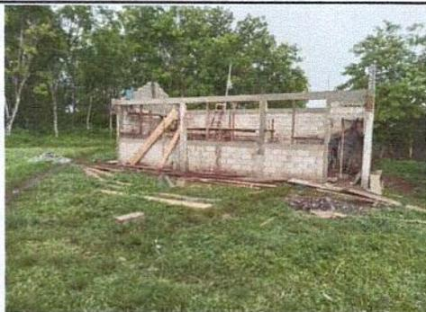
Foto 5: Levantado de paredes y mojinete.
