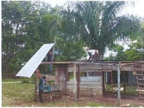
Foto 1: Quitado del techado y paredes de madera.
