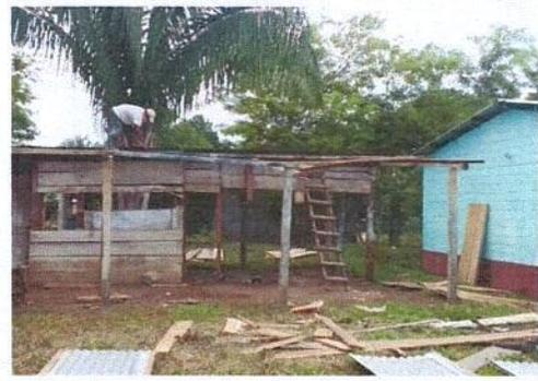
Foto 2: Quitado del techado y paredes de madera.
