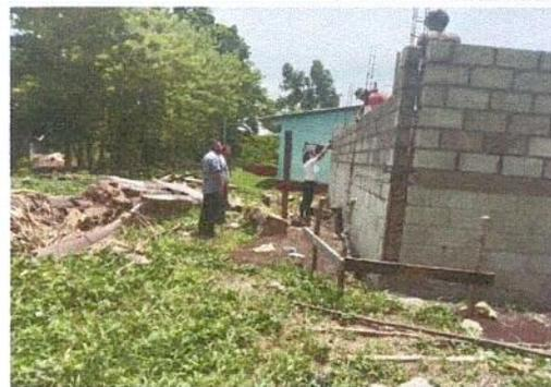
Foto 4: Levantado de paredes y supervisión de la arquitecta.
