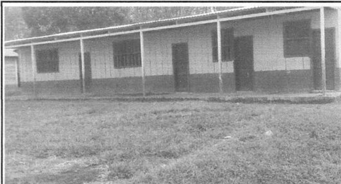
Foto 2: Módulo de tres aulas con paredes de madera
