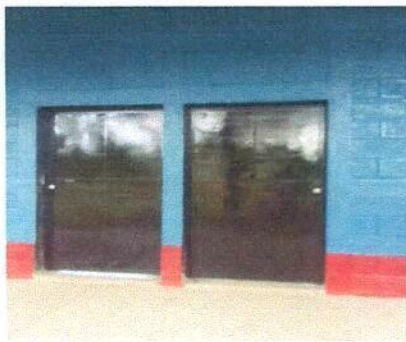
Foto 3: mantenimiento de puertas del Centro Educativo
