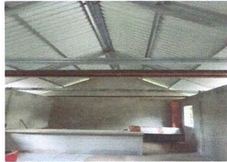
Foto 2: Sustitución de estructura de soporte de madera por metal de la cocina.
