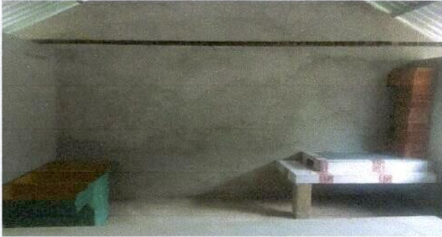
Foto 7: Sustitucion de estufa Rural (Completo)
