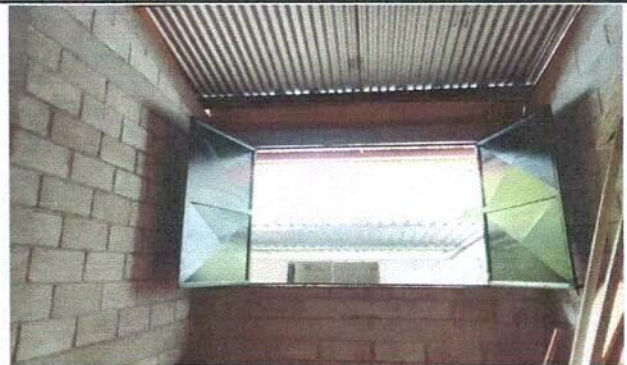
Foto 4: Sustitución de ventana de madera por metal mas vidrio del Centro Educativo
