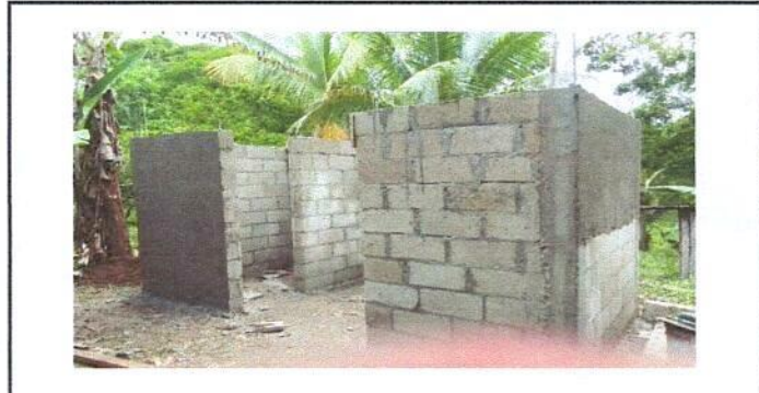
Foto 6: sustitucion de inodoro del servicio sanitarios
