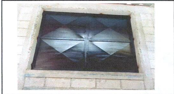
Foto 4: Sustitución de ventana de madera por metal mas vidrio del Cenro Educativo
