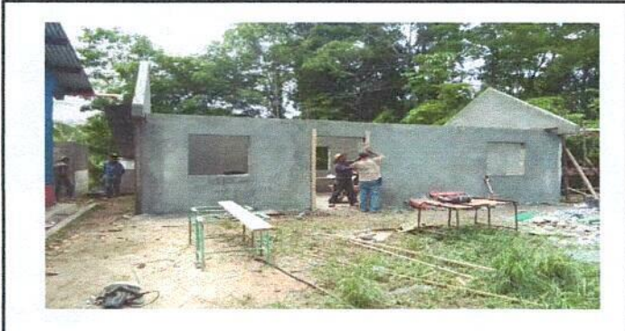
Foto 1: Sustitución de lamina, por lámina troquelada calibre 26 de la cocina.
