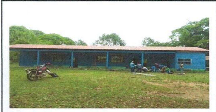
Foto 5: Pintura en muro exterior e interior del Centro Educativo
