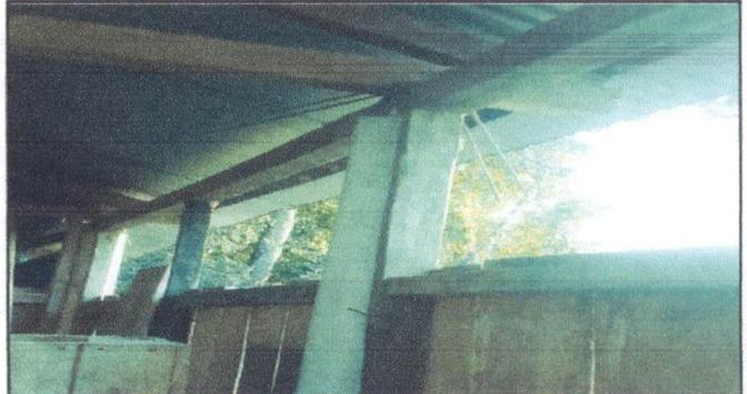
Foto 2: Sustitución de estructura de soporte de madera por metal de la cocina.
